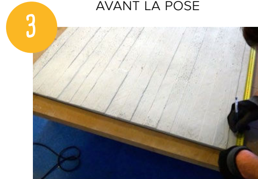
APPLIQUER LES MESURES SUR LE PANNEAU
