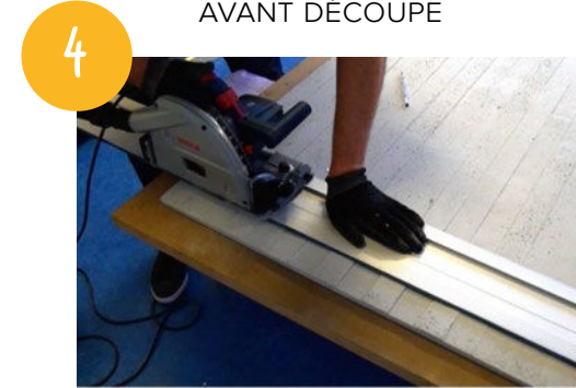
DÉCOUPER À L'AIDE D'UN RAIL DE GUIDAGE
