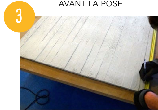
APPLIQUER LES MESURES SUR LE PANNEAU
