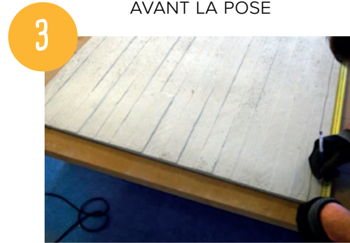
APPLIQUER LES MESURES SUR LE PANNEAU
