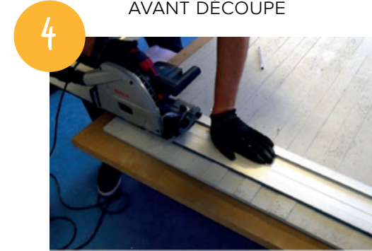
DÉCOUPER À L'AIDE D'UN RAIL DE GUIDAGE
